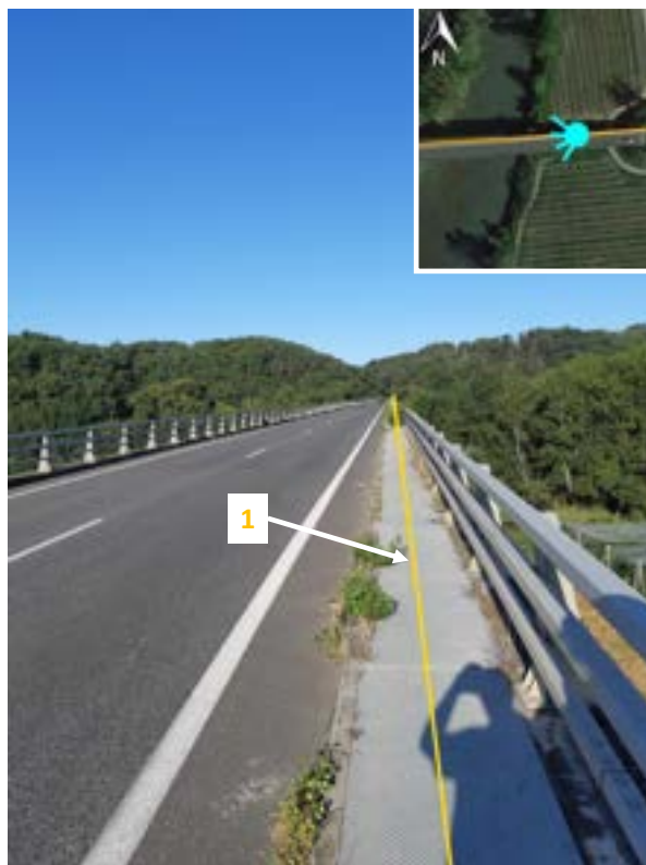
1 : Tronçon C DN150/125/100 BOURRET – MONTAUBAN ZI PARAGES TSOA à déposer Figure 10 : Canalisation DN150/125/100 BOURRET – MONTAUBAN ZI PARAGES en TSOA sur la Garonne
