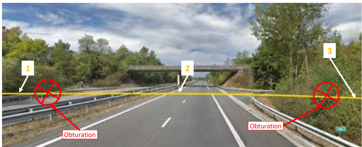
1 : Tronçon H DN150/125/100 BOURRET – MONTAUBAN ZI PARAGES à maintenir dans le sol en l'état - 2 : Tronçon I DN150/125/100 BOURRET – MONTAUBAN ZI PARAGES TSOA à déposer - 3 : Tronçon J DN150/125/100 BOURRET – MONTAUBAN ZI PARAGES à maintenir dans le sol en l'état Figure 14 : Canalisation DN150/125/100 BOURRET – MONTAUBAN ZI PARAGES traversant l'autoroute A62
