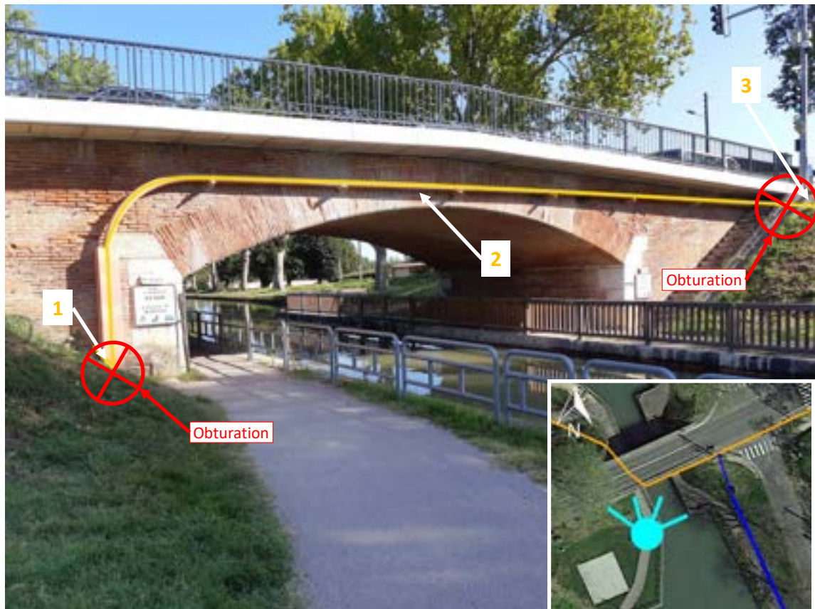
1 : Tronçon F DN150/125/100 BOURRET – MONTAUBAN ZI PARAGES à maintenir dans le sol en l'état - 2 : Tronçon G DN150/125/100 BOURRET – MONTAUBAN ZI PARAGES TSOA à déposer - 3 : Tronçon H DN150/125/100 BOURRET – MONTAUBAN ZI PARAGES à maintenir dans le sol en l'état Figure 13 : Canalisation DN150/125/100 BOURRET – MONTAUBAN ZI PARAGES traversant le canal latéral à la Garonne en TSOA
