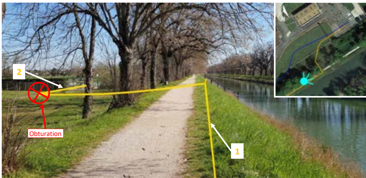
Figure 18 : Canalisation DN100/125/150 MONTAUBAN ZI PARAGES – MONTAUBAN STATION au droit de la TSOA sur le canal de Montech
